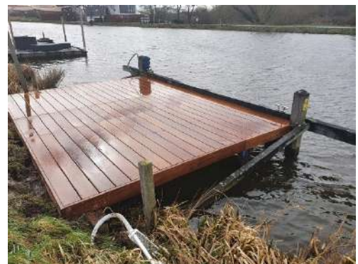
Figuur 43: Een vlonder met een schoorverbinding (Steiger Aan het Water? Van Der Helm Waterbouw!, z.d.)
