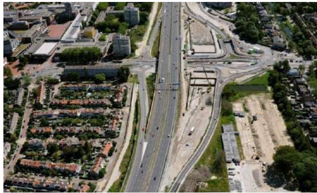
Figuur 1: Luchtfoto van de verbreding vande A9 (Duncker, 2022)
