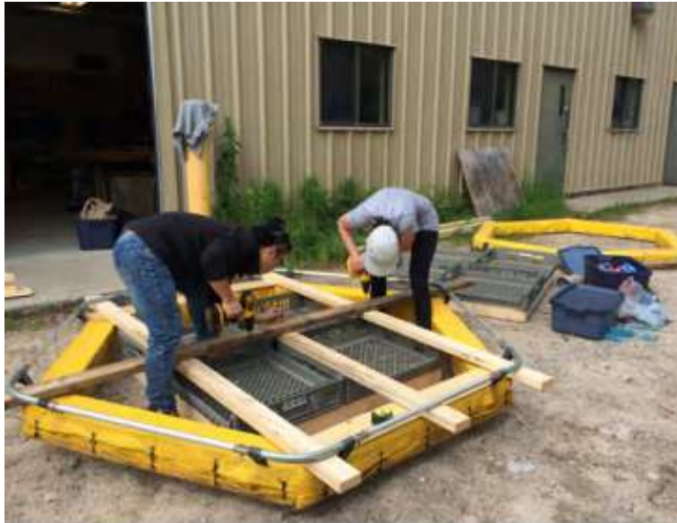
Figuur 49: Afbeelding van het maken van de drijvende wetlandplatformen (Grosshans et al., 2019)
