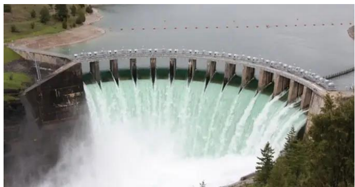
Figuur 14: Voorbeeld van een boogdam (Mat, 2023)
